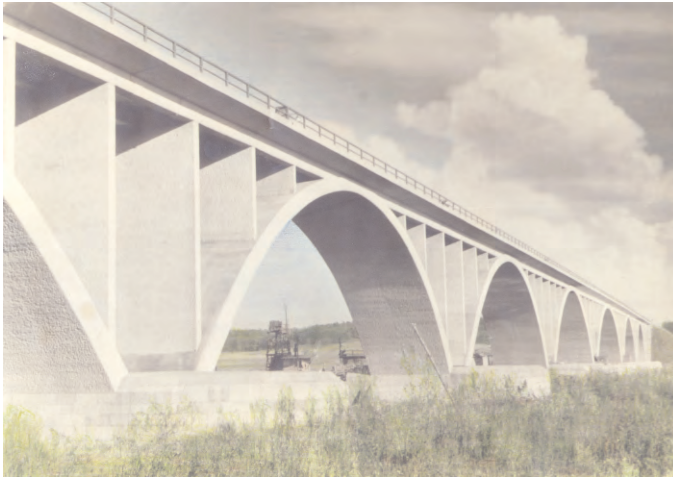
Abb. 3: Privatarchiv des Steinmetz Günter Blazejovsky, Demitz-Thumitz; Die Autobahnbrücke bei Frankfurt/Oder, 1955
