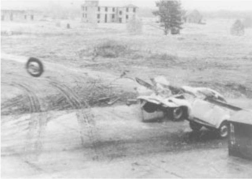
Abb. 4: Im Jahr 1978 experimentierte man mit Stahlschranken für die Grenzübergangsstellen, die den Feind vor dem Verlassen der DDR endgültig stoppen sollten. Aus: BStU, MfS HA VI, 121, Bl. 102 oben.
